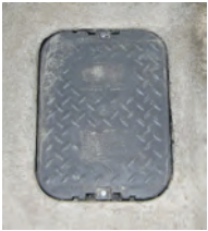
Panneau d'accès au clapet antirefoulement.
